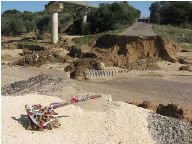
Foto a sinistra - Attraversamento strada comunale distrutto dalla piena Foto a destra – Attraversamento Strada locale di collegamento alla SP4
