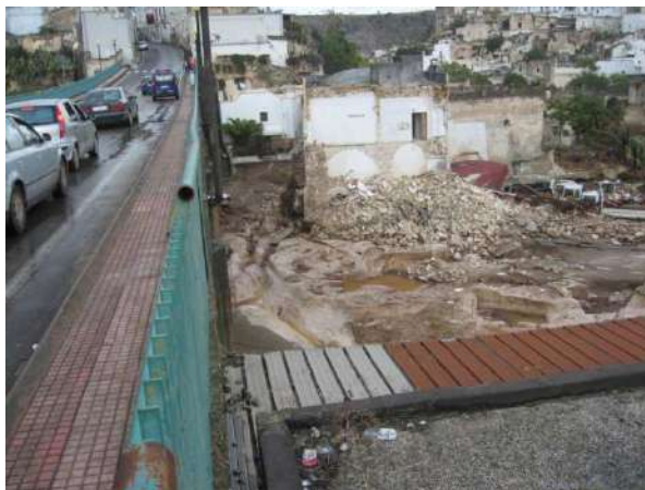
Evento alluvionale ottobre 2013: Ponte San Leonardo Via Puglie/SP ex SS 580 sul Torrente Lognone Tondo nel Centro abitato Ginosa: ostruzione del ponte, crollo di alcune abitazioni, accumulo di fanghi, resti vegetali e rifiuti antropici in alveo e nelle cavità nelle cavità antropiche presenti lungo le sponde
