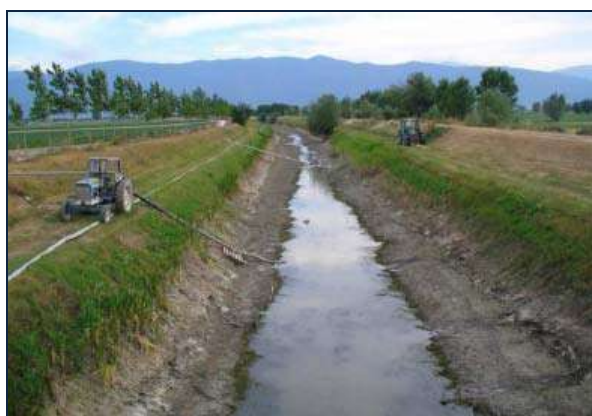
Figura 20. Esempio di prelievo della risorsa idrica ai fini irrigui dai canali della Piana mediante impianti mobili di sollevamento collegati alle macchine agricole.
