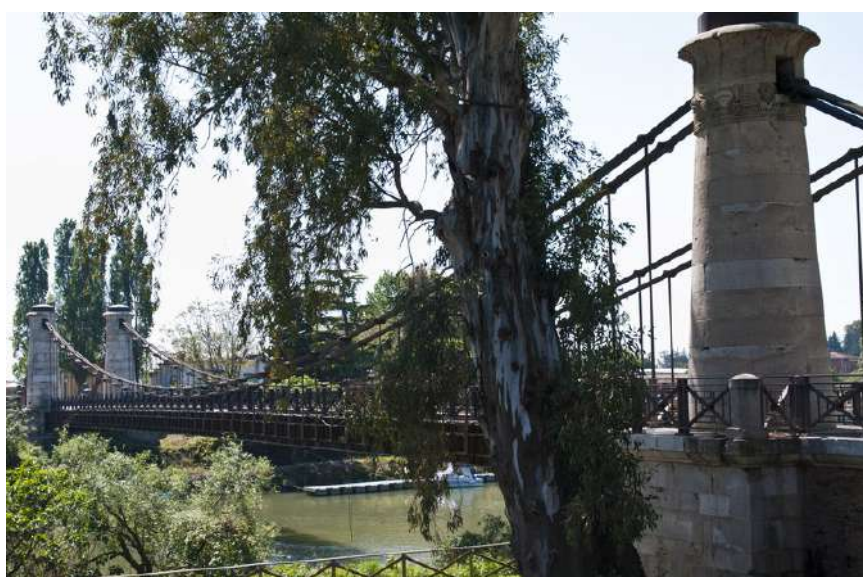
Figura 49– Ponte Borbonico – Sessa Aurunca
