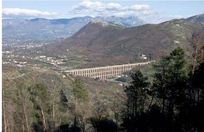
Figura 12 – Acquedotto Carolino Sito Unesco – Caserta
