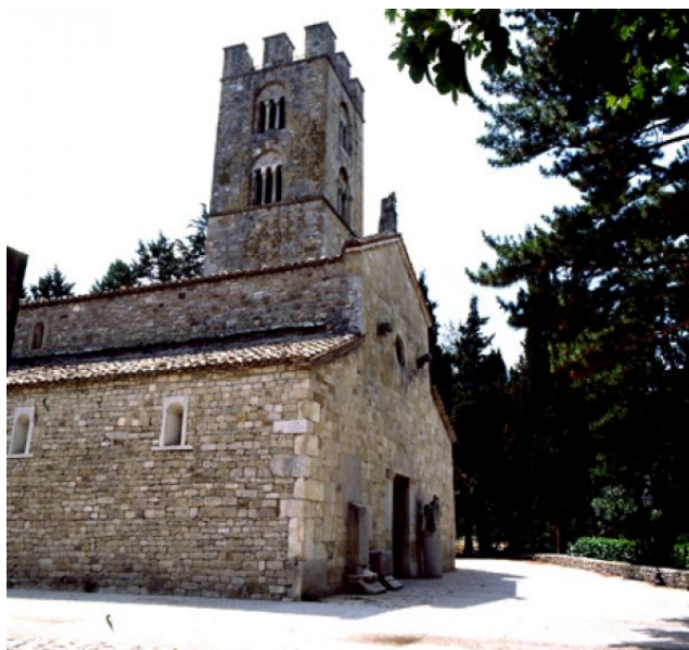
Figura 55 – Il complesso di S. Maria del Canneto sorge nella valle del fiume Trigno, nel punto di confluenza con il torrente Ponte di Musa, nel comune di Roccavivara.
