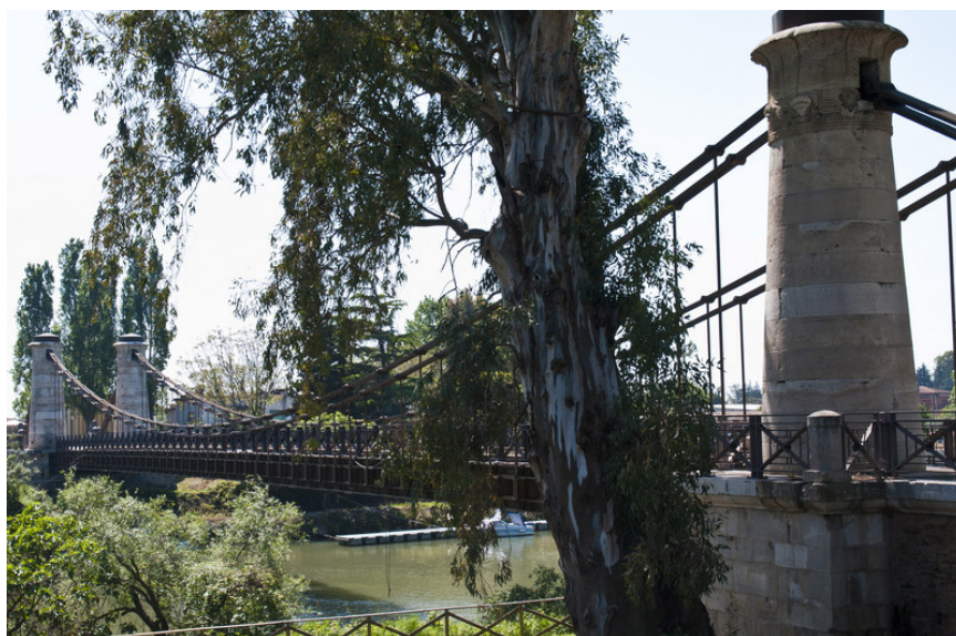
Figura 49– Ponte Borbonico – Sessa Aurunca
