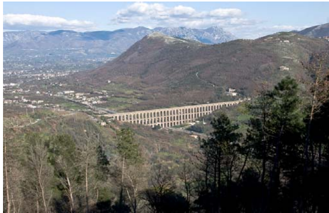
Figura 12 – Acquedotto Carolino Sito Unesco – Caserta
