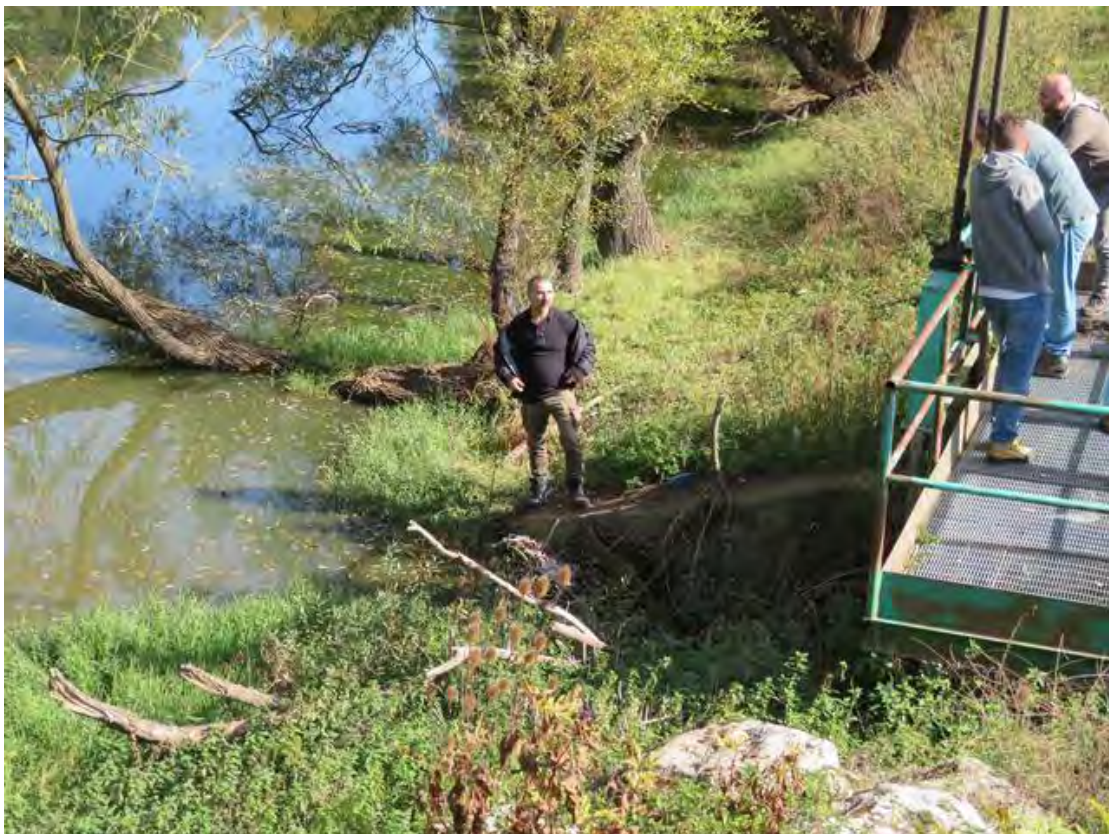
Foto 0028: Lago Dragone - Dettaglio della chiusa
