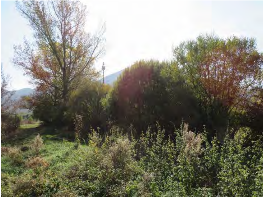
Foto 0038: Canale Coperto Piana del Dragone - Antenna per telefonia
