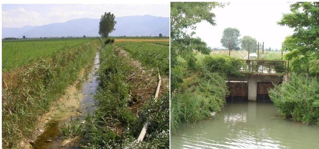
Figura 2.7: La fotografia a destra rappresenta una paratoia e quella di sinistra uno dei canali rilevati.
