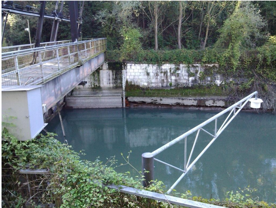
Figura 4.1 – Passerella metallica e idrometro posizionato all'Incile.
