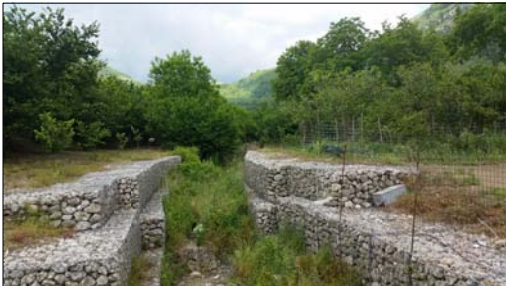
Foto 1 L'asta torrentizia nel tratto terminale prima della sua intersezione con la parte antropizzata del territorio comunale è stata recentemente oggetto di un intervento di sistemazione con la risagomatura delle sponde con l'uso di gabbioni.
