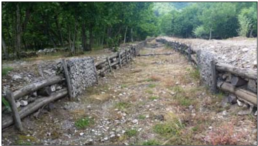
Foto 1 L'asta torrentizia nel tratto terminale prima delle sua intersezione con la parte antropizzata del territorio comunale è stata recentemente oggetto di un intervento di sistemazione con la risagomatura delle sponde con l'uso di gabbioni e palizzate.
